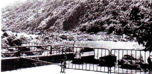
Due gli interventi in esecuzione: la messa in sicurezza di due porzioni di costone lavico con ripristino dei terrazzamenti nei pressi della frana e la ricomposizione della frattura creatasi nelle chiazze (Foto Consoli)
