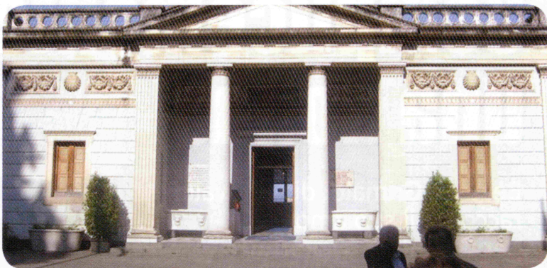
L'ingresso delle Terme di Acireale
